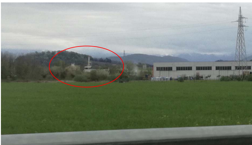
2. Vista da SP 78 in direzione Manzano
